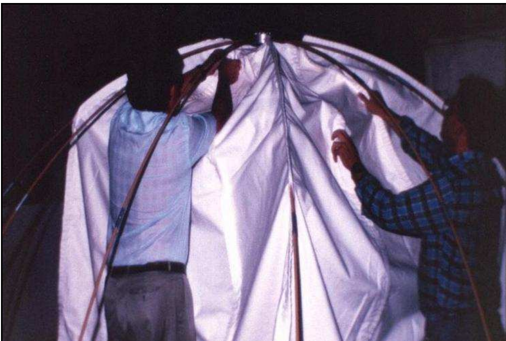
Montaje de la cubierta
