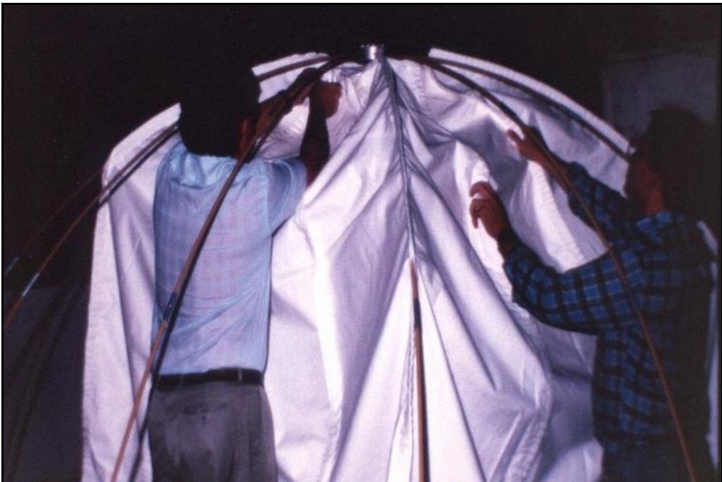
Montaje de la cubierta
